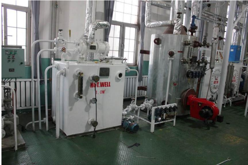
图 1 立式针型管锅炉（图片仅供参考）
