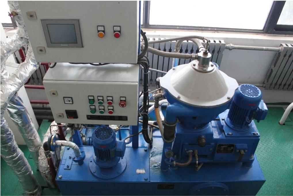
图3 燃油分油机示意图（图片仅供参考）
